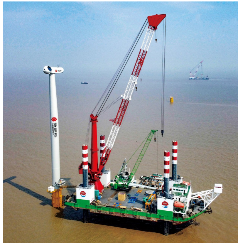
江苏大丰海上风电项目施工现场
