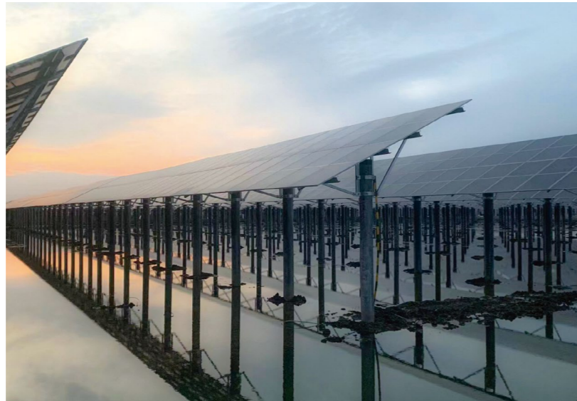
安徽六安 100 兆瓦光伏项目
