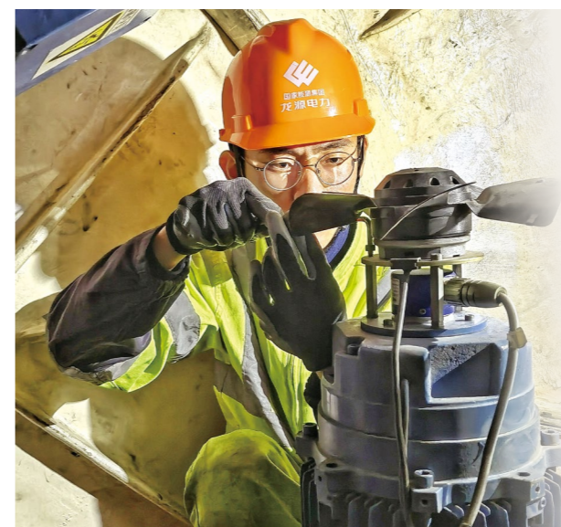
员工在风机内进行检修操作
