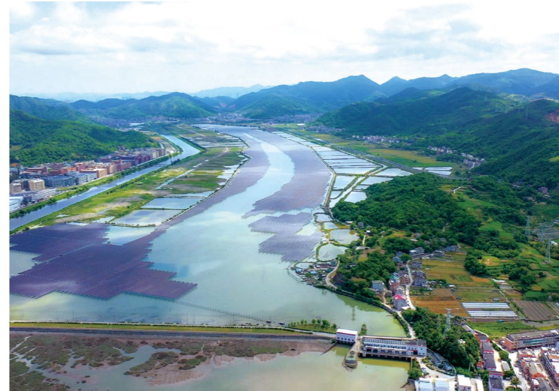
浙江温岭潮光互补型智能光伏电站
