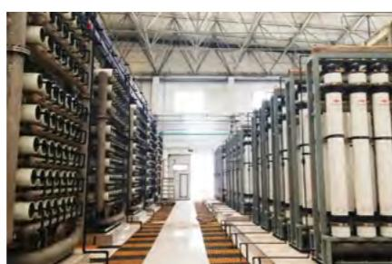
新疆化工污水处理超滤和反渗透系统
